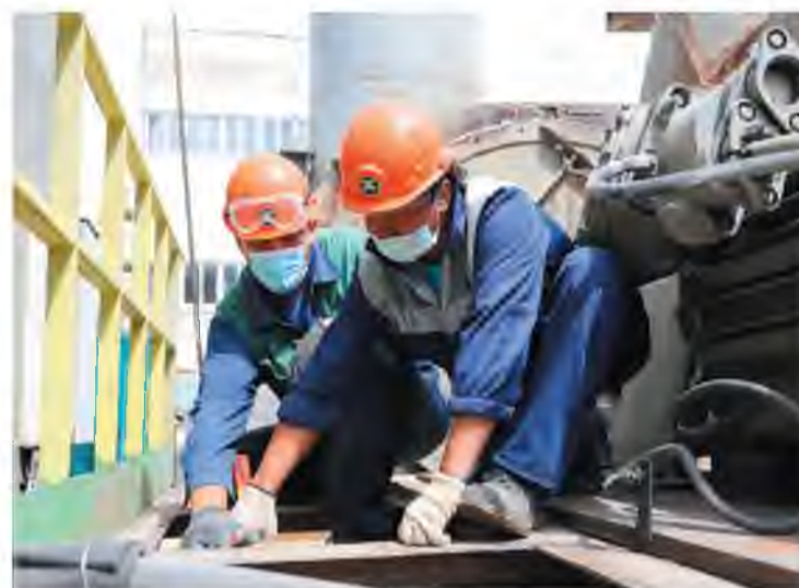
Работники общестроительного участка Максим Зенов и Дмитрий Клементьев ремонтируют фундаменты под технологическое оборудование на первом агрегате карбамида
