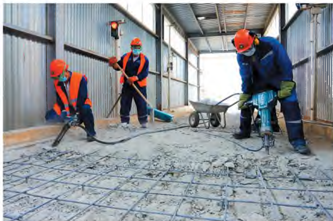
Строители Юрий Оленников, Виктор Дёмин и Дмитрий Вострецов приводят в порядок въездную пандус на автовесовой станции
