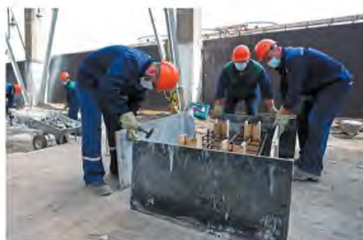
Владимир Карпышов, Роман Лихачёв и Савелий Глушкин ремонтируют фундаменты для насосов
